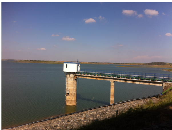
Figura 2.9: Torre de Captação da Albufeira do Roxo
