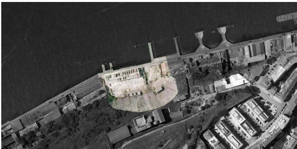
Figura 24: Ortofotocarta relativa ao enquadramento da Área de Intervenção, em destaque. Os Estaleiros Navais Hugo Parry & Son e respectiva área exterior adjacente. Destaque para a escala da superfície côncava, a 'concha' de betão, o Cubal.
