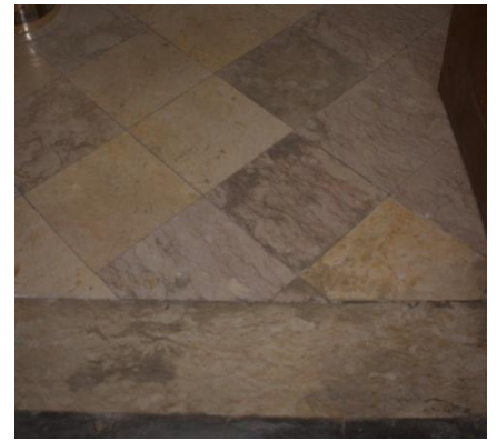
Fig. CXI - Pavimento zona de transição
