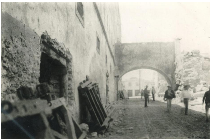
Fig. XLIII - Ponte em alvenaria que ligava o Convento à cerca
