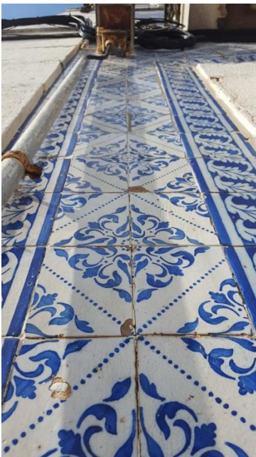
Fig. XCVI - Pannel em azulejo
