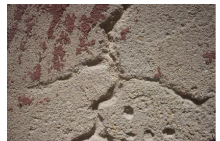
Fig. XLIX - Paredes em alvenaria
