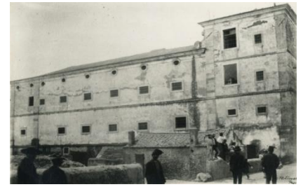
Fig. I - Fachada Nascente Ala Sul
