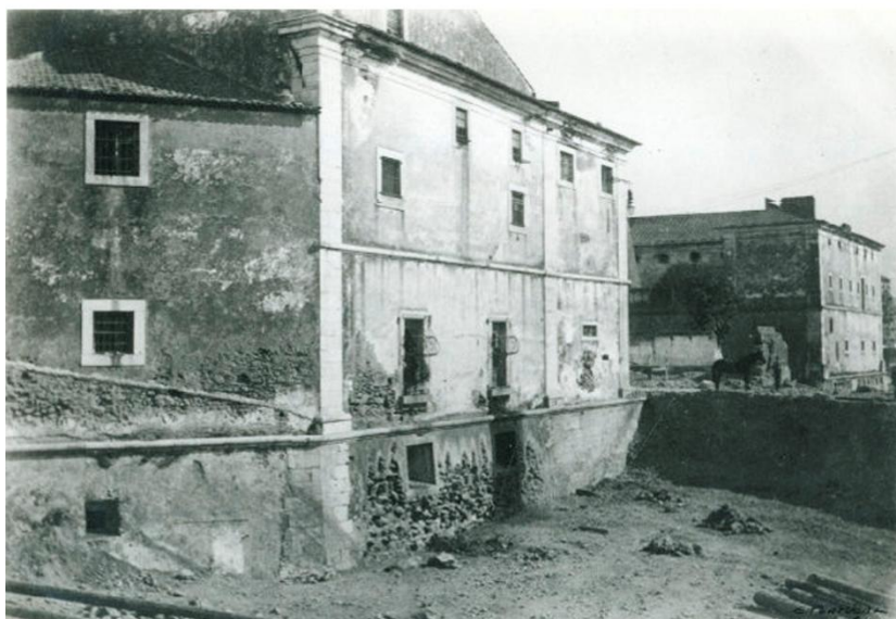
Fig. XXXIX - Alas Sul onde é possível ver o claustro ao centro
