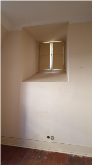
Fig. LXVI - Janelas fachada Noroeste
