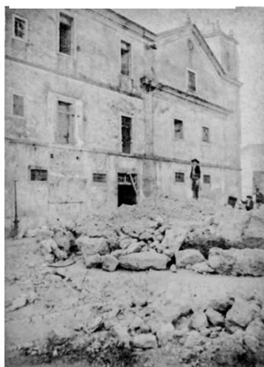
Fig. XLII - Demolição da ponte
