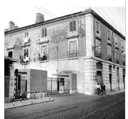
Fig. II - Fachada Ala Norte
