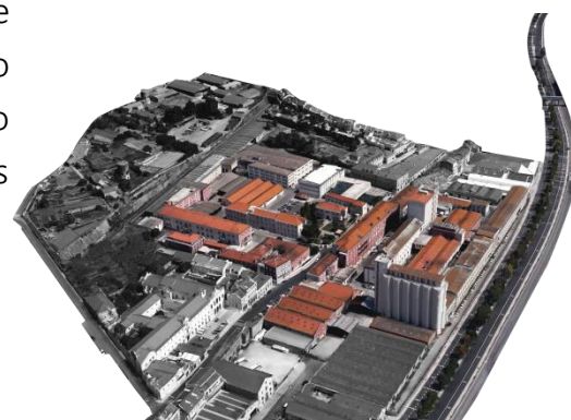
Fig. XXVIII - Vista aérea área de intervenção
