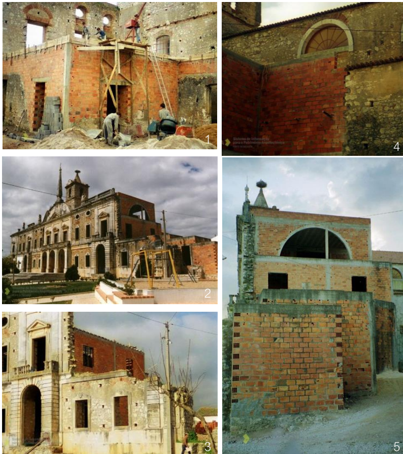
Figura 28 - Esquema temporal das transformações do Palácio: 1/4- Construção do centro de dia; 2/3- Fachada principal do Palácio; 5- Vista lateral da construção do centro de dia (Fonte: SIPA, esquema da planta feito pela autora).
