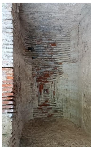
Figura 25 - Arcos de descarga, na zona das janelas, portas e nos tectos abobadados (Fonte: autora).
