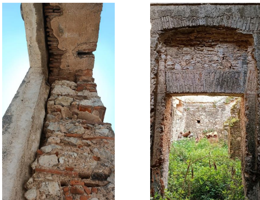
Figura 23 - Paredes de alvenaria ordinária (Fonte: autora).
