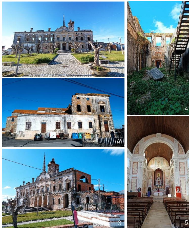
Figura 29 - Esquema temporal das transformações do Palácio: 1- Fachada principal do Palácio; 2- Fachada oeste; 3- Vista do Palácio com parque infantil; 4- Ruína da ala oeste; 5- Zona do altar (Fonte: SIPA, esquema da planta feito pela autora).
