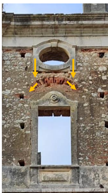
Figura 25 - Arcos de descarga, na zona das janelas, portas e nos tectos abobadados (Fonte: autora).
