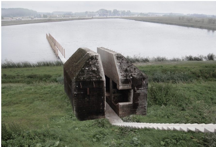
Figura 7: Fotografia pós intervenção, por Allard Bovenberg.
