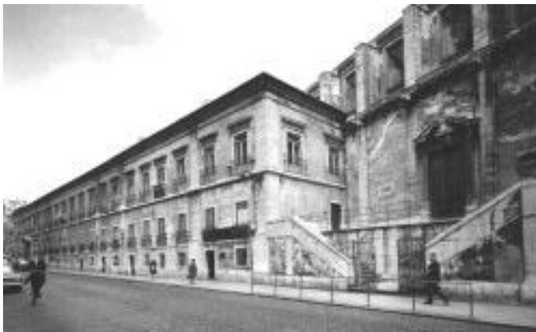
Figura 38 | Fachada principal do antigo Convento de Santa Marta (atual Hospital de Santa Marta) - 1968
