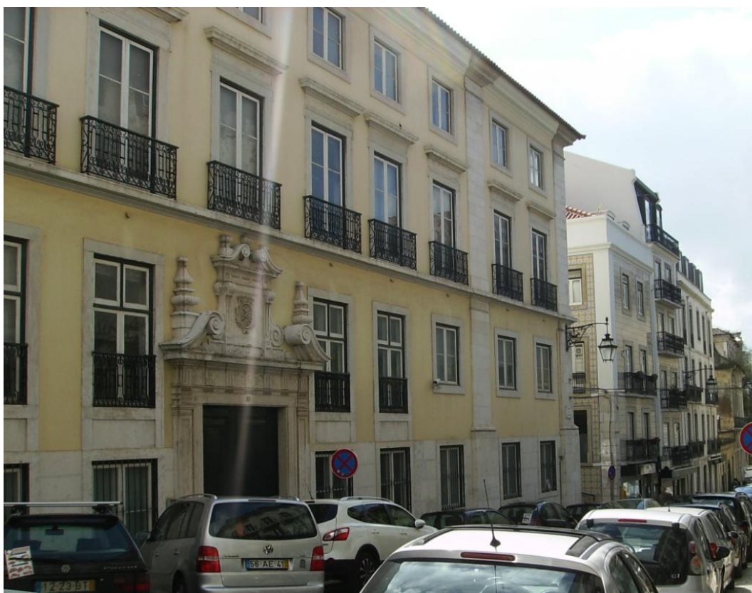
Figura 126 | Palácio na Rua de São José Nº10
