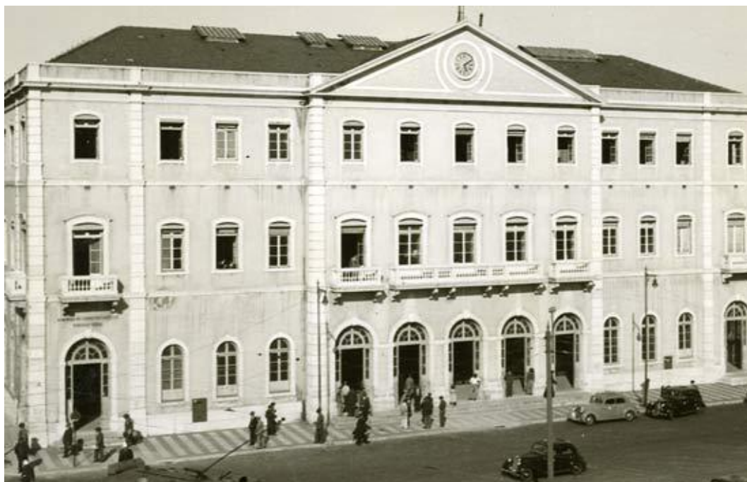
Figura 5 | Estação Ferroviária de Santa Apolónia
