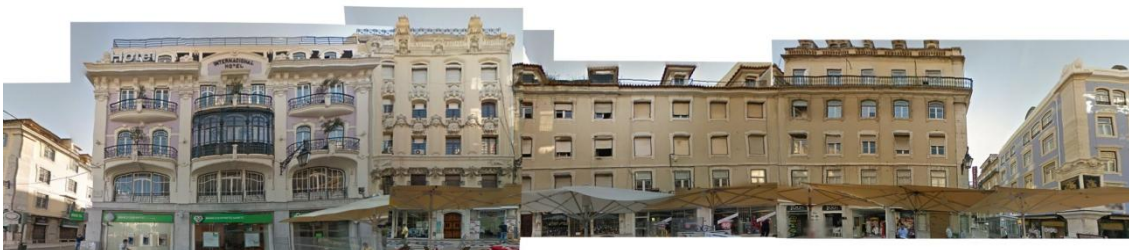
Figura 86 | Rua Augusta - Fachadas
