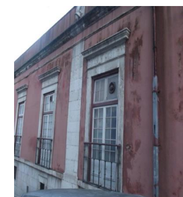
Ilustração 40: Janelas sacadas-fachada principal do bloco A.
