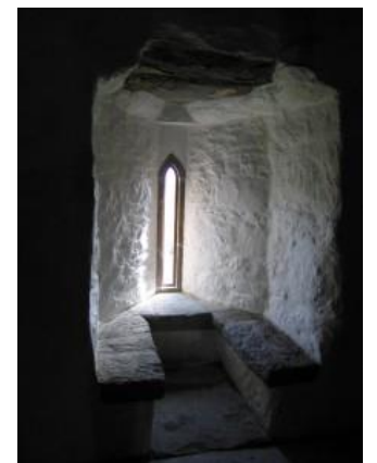
Ilustração 20: Rasgo de luz que se espalha pelas paredes Gallarus-Castle (Irlanda)
