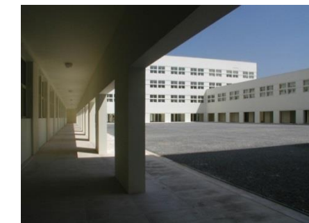
Ilustração 17: Edifício C6 Faculdade de Ciências (Lisboa)
