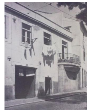
Ilustração 35: Varanda do antigo palácio Tentúgal na Rua do Limoeiro
