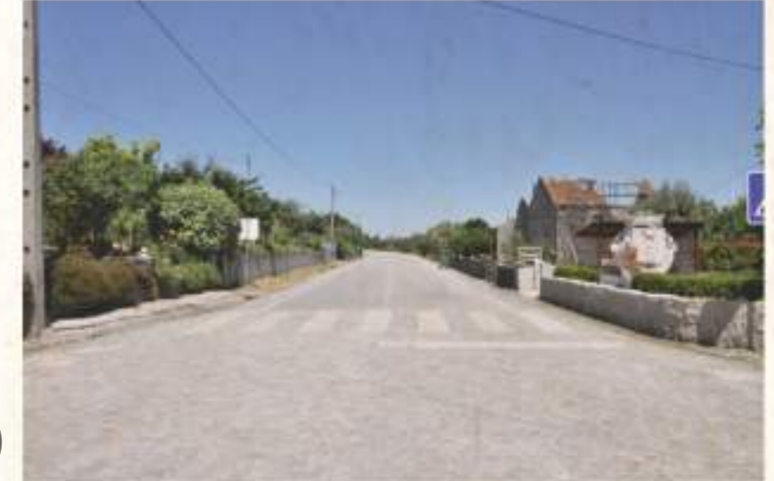
- Cruzamento a norte da Av. 23 de Maio
