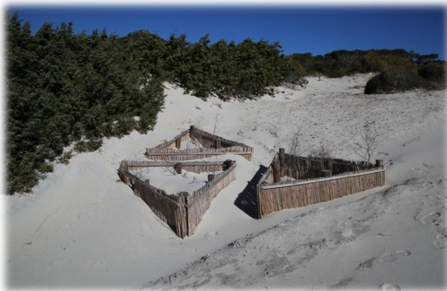
Figura 39: Paliçadas de plantação existentes. Fonte: Autor
