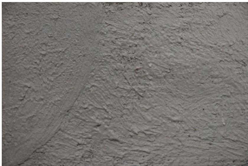
Figura 65. Imagem que retrata a aplicação da camada de preparação com pincel. No canto esquerdo com menos texturização. Fotografia obtida por Beatriz Teodoro©.
