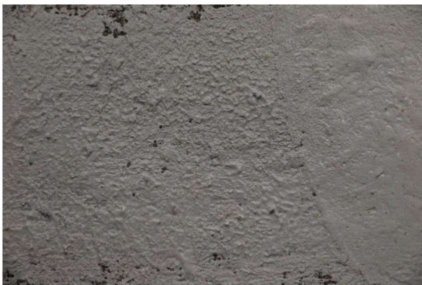
Figura 66. Imagem que retrata a aplicação da camada de preparação com pano. No canto direito com menos texturização. Fotografia obtida por Beatriz Teodoro©.
