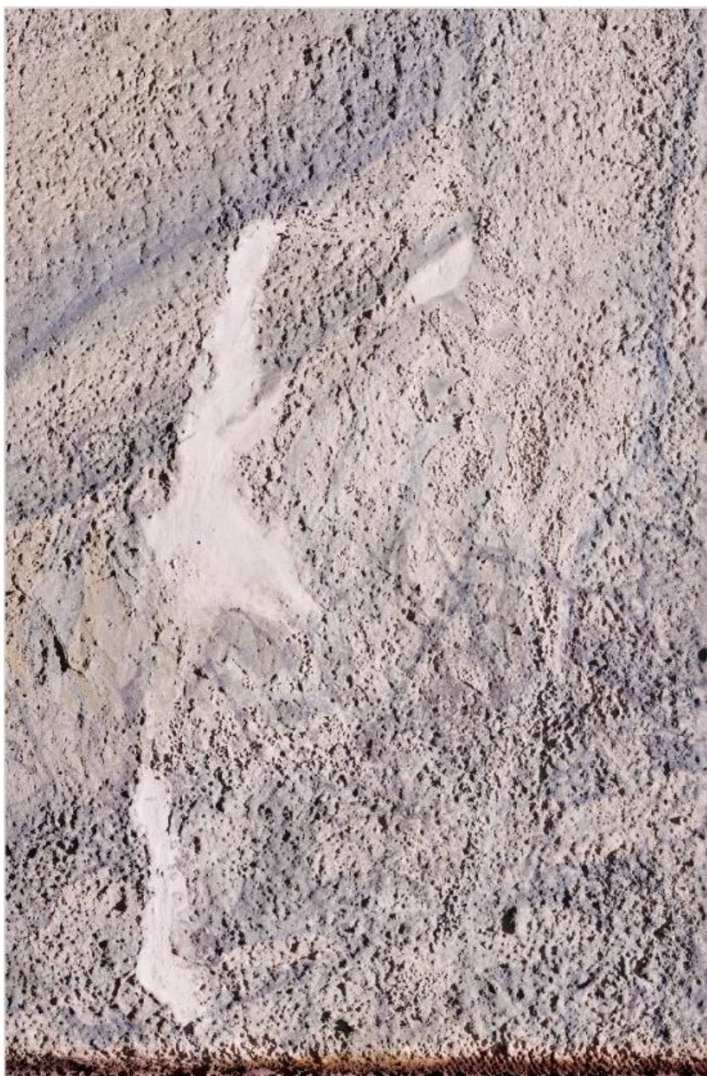
Figura 113. Vista renderizada de pormenor com iluminação rasante de 10°, feito a partir do modelo digital da superfície durante a aplicação das massas de preenchimento. Realizado por Frederico Henriques© no Blender ®.
