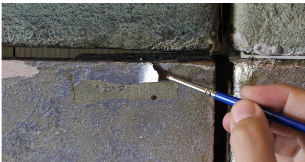
Figura 115. Imagem que retrata o processo de fixação dos destacamentos das pinturas inferiores, neste caso a pintura 4, com recurso a um adesivo e a um pincel. Fotografia obtida por Beatriz Teodoro©.
