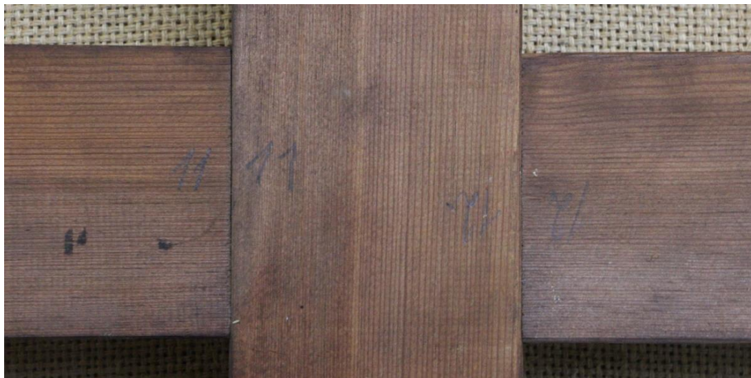
Figura 40. Imagem do pormenor da grade da pintura 3, onde é possível observar as marcas de marceneiro com numeração, que indicam pontos de ligação das peças de madeira (samblagem). Fotografia obtida por Beatriz Teodoro©.
