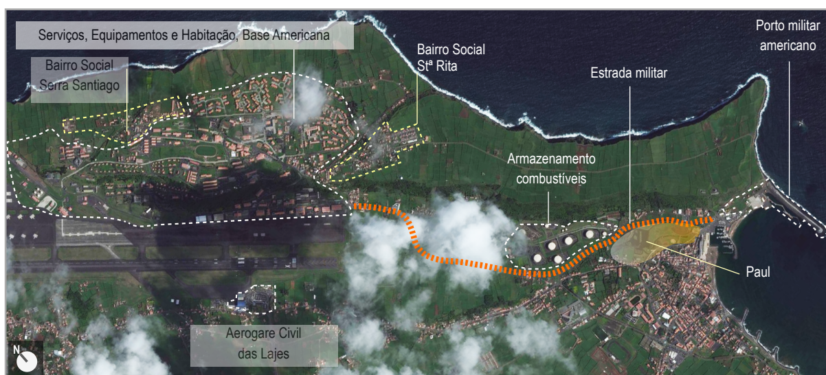
Figura 25 - Infraestruturas relacionadas com a BA4 (Bing Maps 2012)
