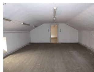
Fig. 66 | 2º piso do Dispensário de Alcântara. (fotografia da autora)
