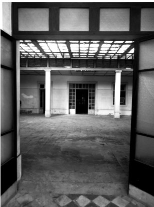
Fig. 44 | Entrada actual do Dispensário de Alcântara. (fotografia da autora)
