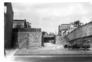
Fig. 53 | Avenida Infante Santo em construção em 1950. Fotografia de Eduardo Portugal no Arquivo Fotográfico da C.M.L. ( http://biclaranja.blogs.sapo.pt/arquivo/1068361.html )
