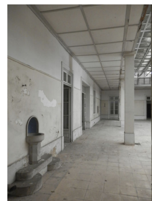
Fig. 47 | Situação actual do espaço central do Dispensário de Alcântara. (fotografia da autora)
