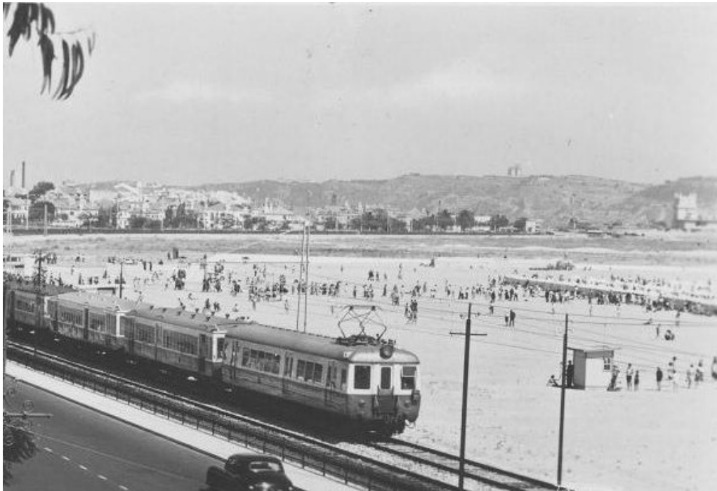
Fig. 2 - Fotografia do Séc XX da Linha do Comboio de Cascais e a Praia em Algés| Município de Oeiras . Passaporte, António.
