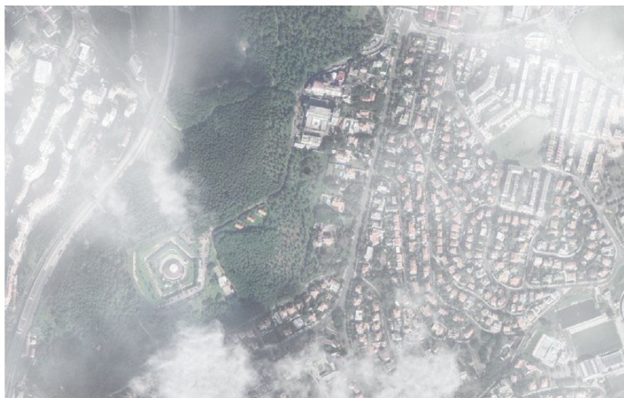
Fig. 45 | Fotografia aérea do local de intervenção
