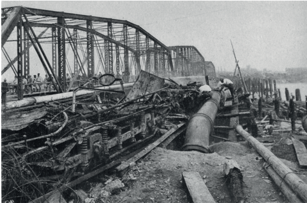
25 Ponte Eitai-bashi queimada depois dos incêndios provocados pelo terramoto, 1923.
