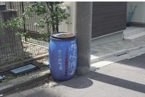
97 Os reservatórios com água estão dispersos pelo bairro, para combater os potenciais incêndios.
