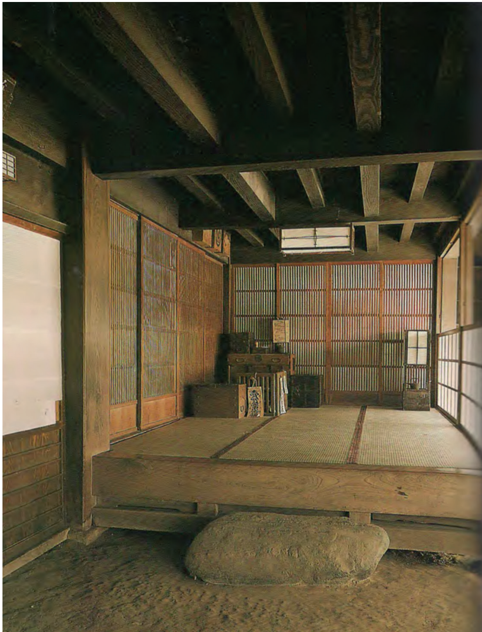
59 Exemplos da entrada genkan , um dispositivo de transição, onde o visitante, ou habitante retira os sapatos antes de aceder ao piso elevado e ao interior do espaço.
