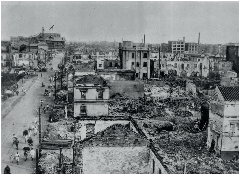
28 Vista de Ginza após o terremoto, 1923.
