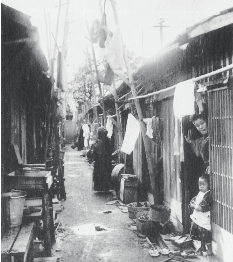
102 Fotografia da habitação urbana tradicional nagaya , para os habitantes com menos recursos, que ocupam o interior de lotes longos. O senhorio destes complexos de habitação, gere e habita, por norma, as habitações machiya que se alinham na parte frontal das nagaya , enquanto os seus empregados e os artesãos habitam as traseiras de sua casa, acedidas por um rua longa e estreita. à semelhança das ilhas na cidade do Porto.
