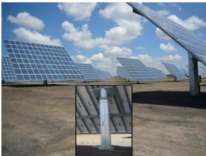
Figura 2.16 Seguimento azimutal da central fotovoltaica da Amareleja, Portugal [37]
