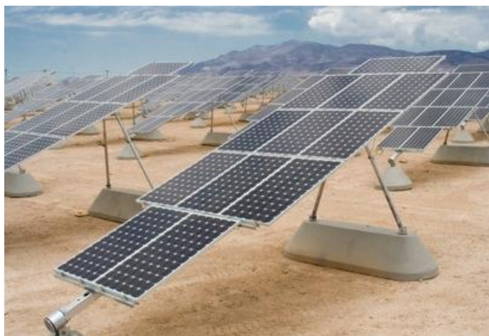
Figura 2.17 Seguimento polar da central fotovoltaica Nellis, EUA [30]
