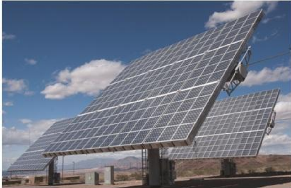
Figura 2.21 Sistema concentrador fotovoltaico [35]
