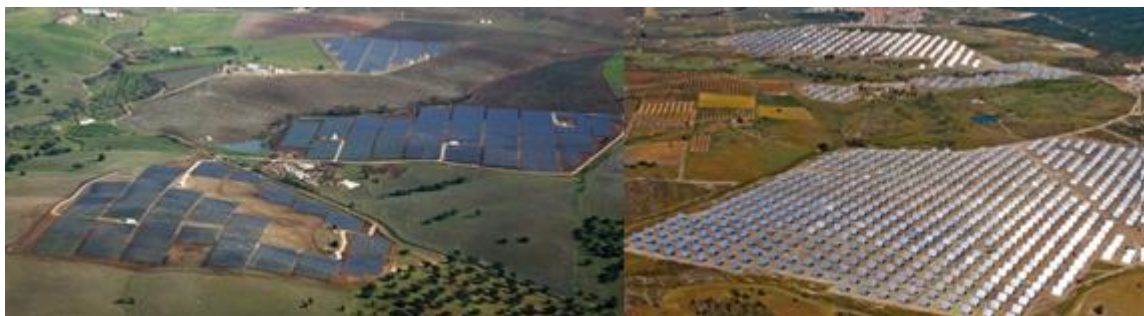
Figura 2.15 Centrais fotovoltaicas de Serpa e Amareleja [37]
