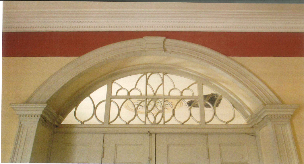
Pormento da bandeira de uma das portas em fole na Casa Read (Foto do autor, 2017).
