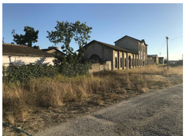
10 - EDIFÍCIO FERROVIÁRIO A RECONVERTER NUM MERCADO (2021).
