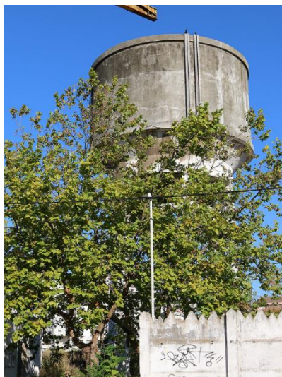
Imagem 47 – Uma das torres de água, anexa à Rotunda das Locomotivas. Fonte: APAC, 2016.
