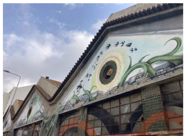
9 - OFICINAS NO FINAL DA AVENIDA DA REPÚBLICA (2024).
