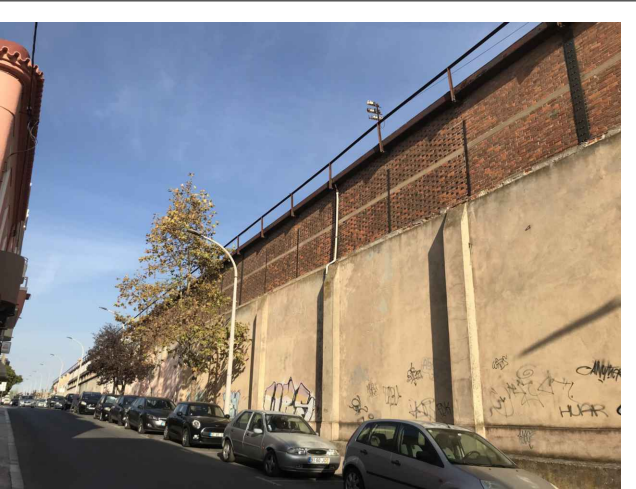
6 - O MURO DAS OFICINAS DA QUE CRIA UMA BARREIRO FÍSICA E VISUAL (2021).
