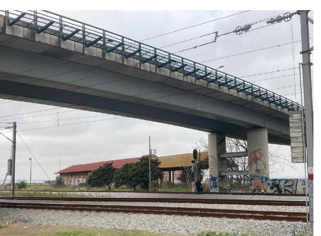
18 - CAMINHO INFORMAL DEBAIXO DO VIADUTO (2024).
