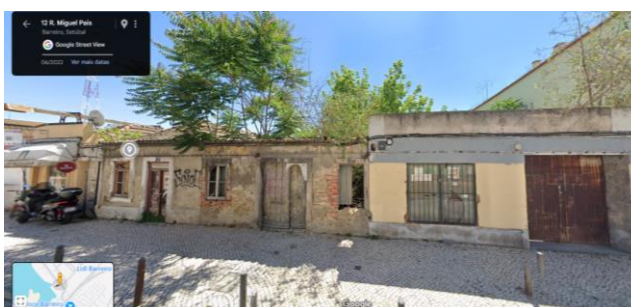
Imagem 43 – Edifícios em ruínas no final da Rua Miguel Pais. Fonte: Google Maps, 2022.
