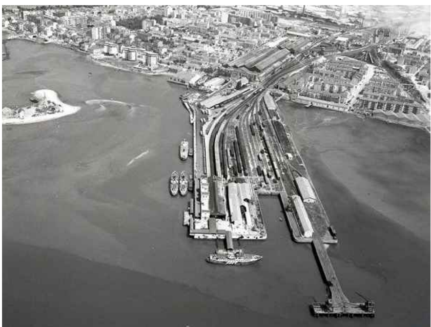
1981 - VISTA ÁEREA DO TERMINAL FERRO-FLUVIAL DO BARREIRO COM TODAS AS SUAS INFRAESTRUTURAS.
