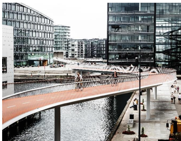
Imagem 54 – The Bicycle Snake em Copenhaga (Dinamarca), é uma ponte para ciclistas e representa a capital dinamarquesa na sua essência. Sustentável e primando pelo espaço público enquanto espaço para todos como destacado pelo urbanista Jan Gehl. Fonte: Diário de Notícias 2025; Fotografia de Rasmus Hjortshøj, 2020.
