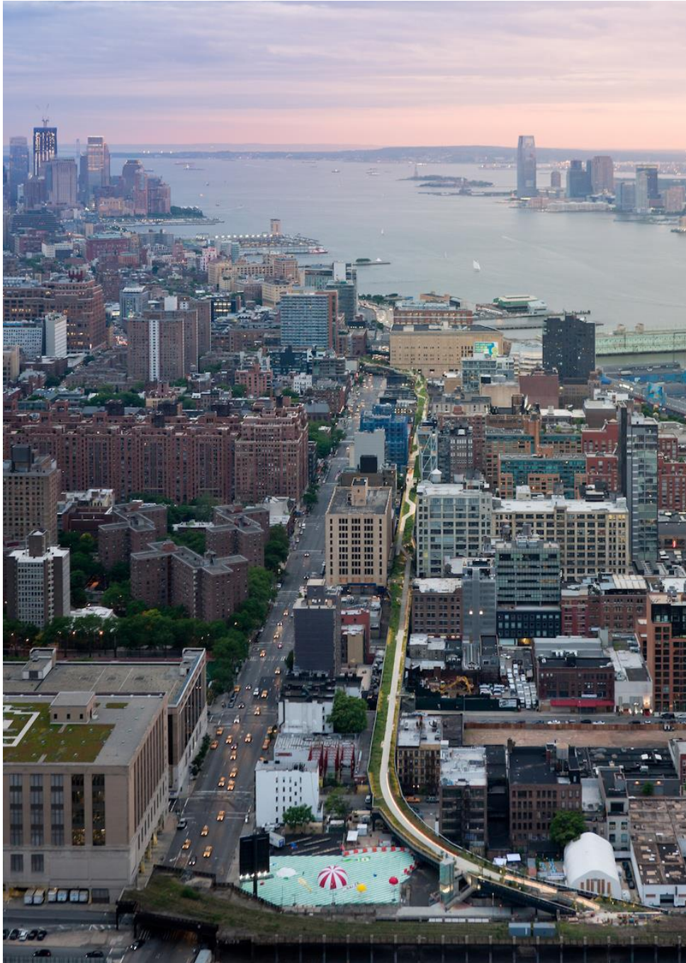
Imagem 15 - Vista aérea do Parque High Line, em Nova Iorque (Estados Unidos da América). Fonte: Diller Scofidio + Renfro, s.d.
