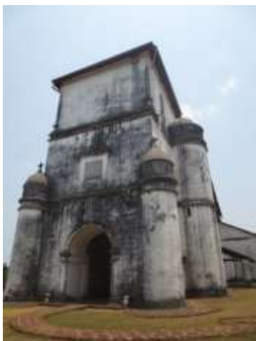
Imagem 222 A igreja de Nossa Senhora do Rosário com a sua torre-fachada e os contrafortes e torres cilíndricas adossados a este corpo.
