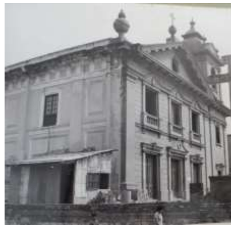
Imagem 305 Aspecto da igreja aquando dos trabalhos da década de 50, c. 1954. AHU, IPAD, MU, DGOPC, GTPM, 2220, 00620.
