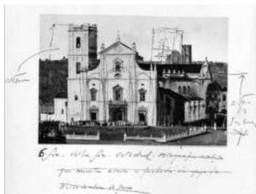
Imagem 267 Estudo de reconstrução da torre direita da catedral por Mário Chicó sobre uma fotografia de Souza & Paul. FMS, FMAC, pt. 05519.000.104.
