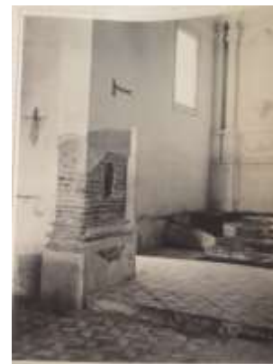
Imagem 107 O arco triunfal após a picagem do estuque. Ao fundo vêem-se os degraus de alvenaria que antes desta intervenção estavam encobertos por outros mais recentes, 1956. AINPCA, pt. 28.1.
