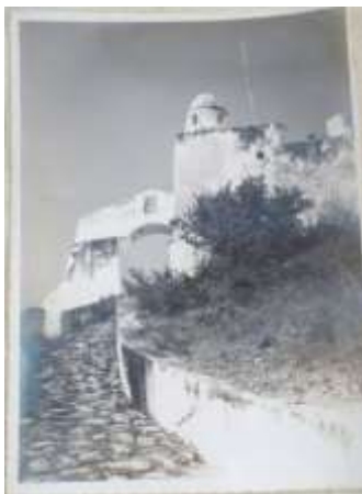
Imagem 116 Aspecto da fortaleza da Muxima com os rebocos em mau estado de conservação, 1955. AINPCA, pt.11.1.
