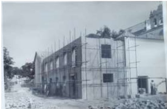
Imagem 160 Aspecto das obras exteriores com parte das paredes rebocadas, 1956. AINPCA, pts. 26.2 e 26.3.
