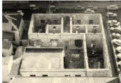
Imagem 196 Vista do interior da Casa Amarela aquando as obras de restauro e adaptação a museu, 1970. Delagoabayworld.wordpress.com.
