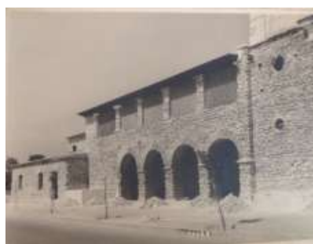
Imagem 109 Aspecto da galeria e da antiga sacristia da igreja após a picagem dos rebocos, 1959. AINPCA, pt.28.2.
