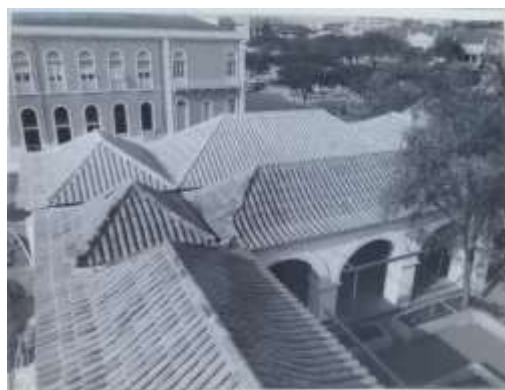
Imagem 162 Vista da cobertura da igreja, do vestíbulo, residência paroquial e de parte do claustro, 1957. AINPCA, pts. 26.2 e 26.3.
