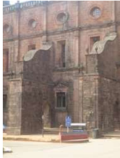
Imagem 272 Pormenor dos arcobotantes da parede lateral norte.
