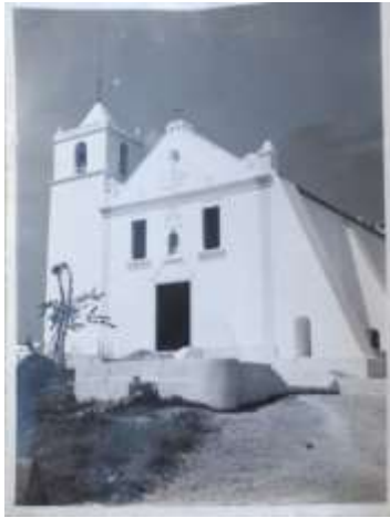
Imagem 117 Aspecto da igreja de Nossa Senhora da Conceição da Muxima impecavelmente rebocada, 1955. AINPCA, pt. 12.
