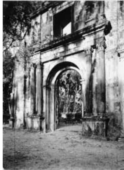
Imagem 250 O que restava das ruínas da mesma igreja no ano de 1951, notando-se a reconstrução do nicho do lado esquerdo e a ausência dos vestígios dos frontões triangulares dos portais laterais. FMS, FMAC, pt. 07127.000.212.
