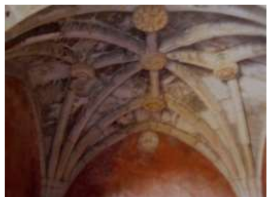
Imagem 68 Pormenor da abóboda nervurada da capela-lateral.
