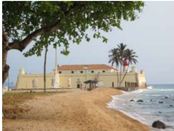
Imagem 11 Vista da fortaleza de São Sebastião com uma face virada a terra, duas ao mar e uma para a praia PM.
