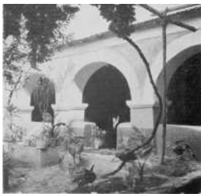
Imagem 161 Pormenor do claustro antes do restauro, c. 1953. Como se percebe pela próxima fotografia o murete que ligava os pilares foi eliminado após a intervenção. Boletim do Instituto de Angola nº1, 1953.
