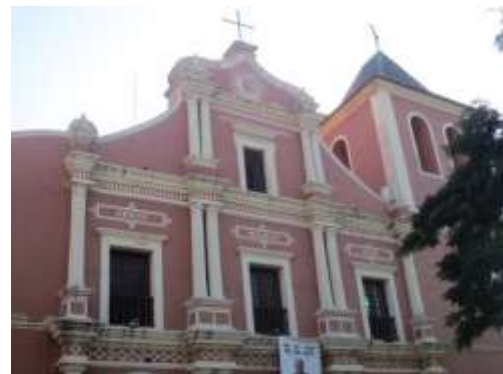
Imagem 140 Um pormenor da fachada da mesma igreja na actualidade. Observem-se as diferenças ao nível da torre, aqui sem o relógio, com aberturas em forma de arco de volta-perfeita e coroaamento piramidal.
