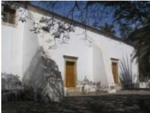
Imagem 66 Pormenor da fachada sudeste com os respectivos contrafortes.
