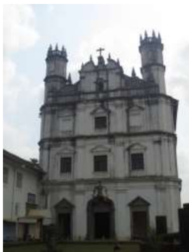
Imagem 220 Fachada da igreja do Espírito Santo do convento de São Francisco de Assis.
