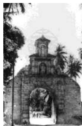
Imagem 239 O arco sem reboco e com a base desenterrada. A fotografia data possivelmente de um momento posterior à intervenção de Baltazar Castro e anterior ao desmoronamento. ACTDC/IICT, nº129.
