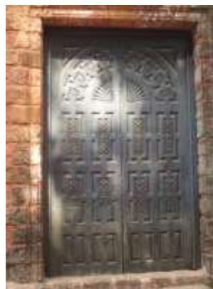
Imagem 243 Pormenor da porta talhada trazida dos escombros de São João de Deus.
