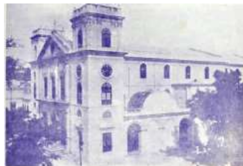
Imagem 318 Vista da fachada lateral após o restauro de 1937. Note-se que a galeria lateral está parcialmente fechada e apresenta uma nova cobertura. Eusébio Alvarez, "Macau, Mãe das Missões no Extremo Oriente", 1957.
