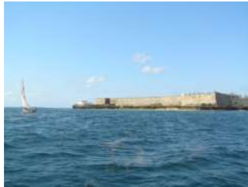
Imagem 164 Vista da fortaleza de São Sebastião e da capela de Nossa Senhora do Baluarte.
