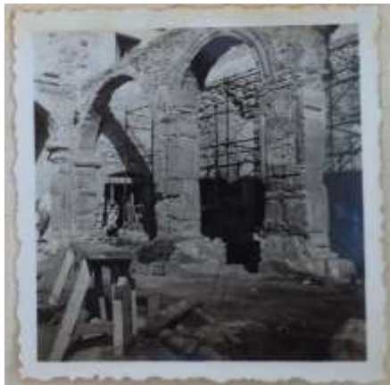
Imagem 135 Aspecto das obras efectuadas no interior da igreja de Jesus nos anos de 1953-1954, s/d [1953-1954]. AINPCA, pt.
