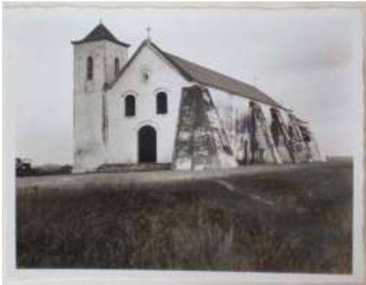
Imagem 125 O exterior da igreja, c. 1961, com os contrafortes carentes de reboco. IPAD, MU, DGOPC, DSUH, 1992, 01479.
