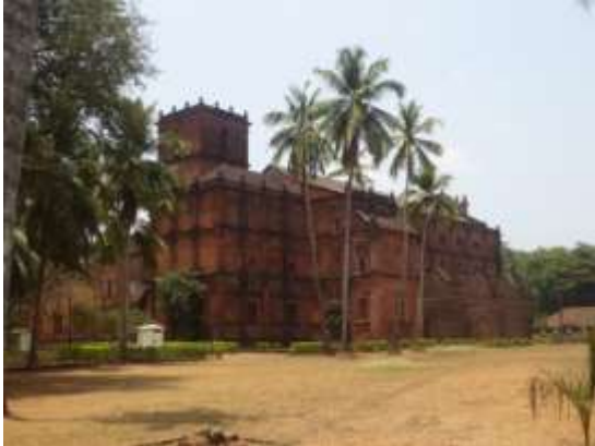
Imagem 271 Fachada posterior da igreja, sendo bem visíveis a torre, os corpos da capela-mor e a capela do transepto.
