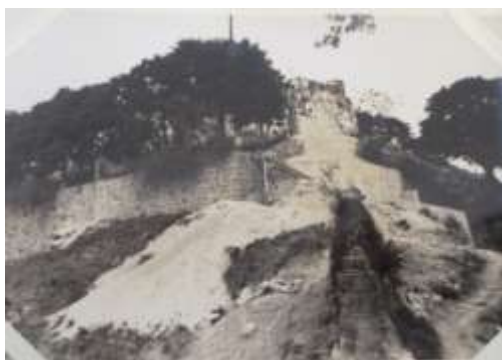
Imagem 307 Aspecto das obras de consolidação da muralha no ano de 1934/1935. AHU, OP01961, 8/60-2/2, MU, DGOPC, CDTE, doc. s/n.
