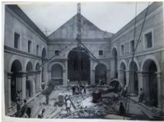
Imagem 137 Momento em que se procedia à elevação e assentamento da asna de ferro da cobertura da igreja, 1958. AINPCA, pt. 29.7
