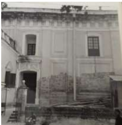
Imagem 304 Aspecto exterior da igreja com as paredes parcialmente picadas aquando da campanha dos anos 50, c. 1954. AHU, IPAD, MU, DGOPC, GTPM, 2220, 00620.
