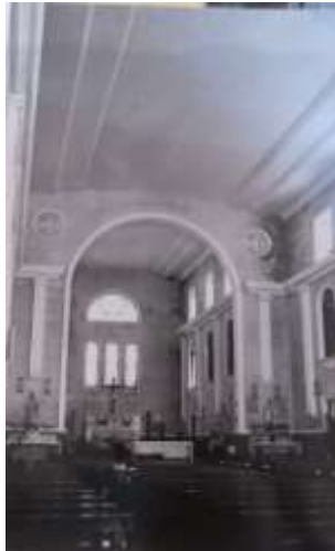
Imagem 319 No início dos anos 70 a igreja já apresentava sinais de deterioração, nomeadamente ao nível das paredes interiores, 1973. AHU, IPAD, MU, DGOPC, GTPM, 2220, 00528.
