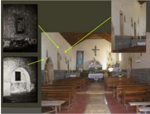
Imagem 78 Interior da igreja com destaque para o antes e depois do restauro que implicou o levantamento dos azulejos da parte superior da parede na qual se encontra o púlpito e a capela/entrada entaipada. ANTT, FLB, cx. 116, pt. 777, doc. 23.
