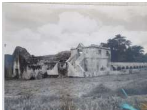
Imagem 95 Parte das ruínas da Real Fábrica de Ferro de Nova Oeiras, s/d [anos 50 ou 60]. AINPCA, pt. nº19.1.
