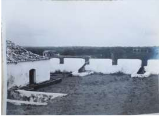
Imagem 121 Aspecto do interior da fortaleza de Massangano, 1955. AINPCA, pt. 2.2.
