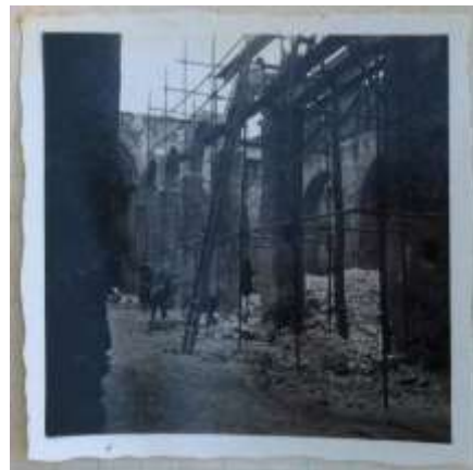
Imagem 136 Aspecto da igreja aquando da demolição da arcaria central do corpo do edifício, 1953. AINPCA, pt. 29.6.
