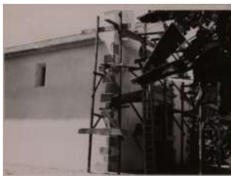
Imagem 42 Momento em que se ultimavam as obras da fachada principal, c. 1964. ANTT, FLB, cx. 96, pt. 631, doc. 3.
