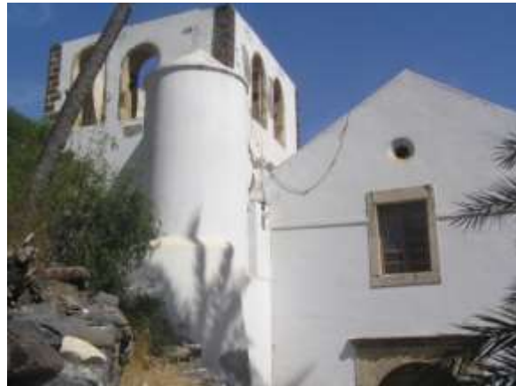
Imagem 65 Pormenor da torre cilíndrica, da torre sineira sem cobertura e da empena triangular.
