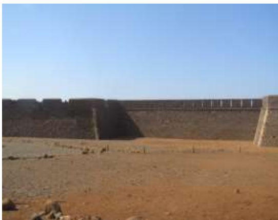
Imagem 43 Vista da fachada virada a nordeste com o meio baluarte à direita e o baluarte de São Gonçalo à esquerda.
