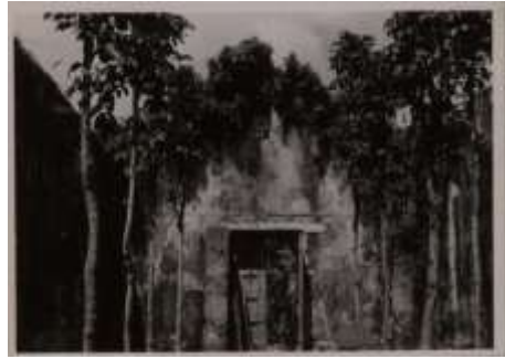
Imagem 13 Vista da nave da igreja da Madre de Deus sem cobertura e invadida por vegetação, c. 1956-1959. ANTT, FLB, cx.96, pt. 631, doc.7.
