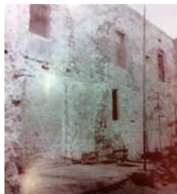
Imagem 193 Aspecto da fachada lateral esquerda do convento de São Domingos aquando dos trabalhos de levantamento dos rebocos. São visíveis dois níveis de arcaria do antigo claustro. Monumenta nº8, 1972.
