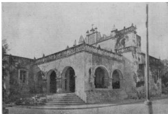
Imagem 203 A igreja da Misericórdia com o alpendre adossado à fachada principal. Moçambique – Documentário Trimestral nº42, 1945.
