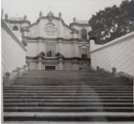
Imagem 294 Fachada da igreja revestida de “Shangai Plaster”, c. 1953. IPAD, MU, DGOPC, GTPM, 2220, 00620.
