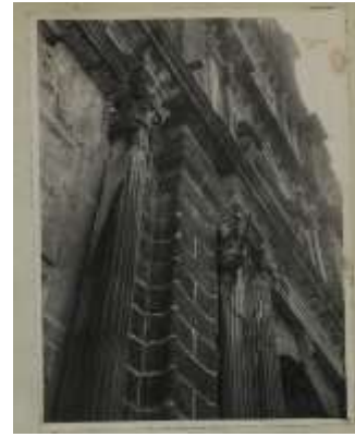
Imagem 281 Pormenor da alvenaria da fachada sem reboco, 1959. ANTT, FLB, cx. 4, pt. I, doc.4.
