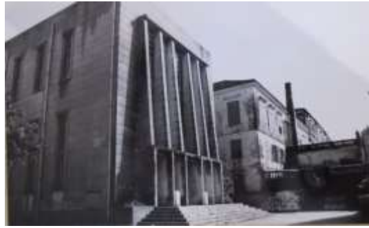
Imagem 295 Pormenor do edifício moderno do seminário igualmente revestido de “Shangai Plaster”. IPAD, MU, DGOPC, GTPM, 2220, 00528.
