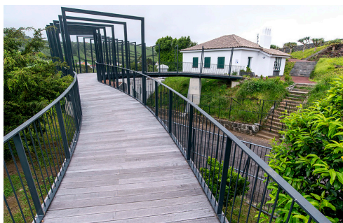
Fig. 1.1 – Ponte de acesso à última área de ampliação do Jardim Botânico do Faial.
