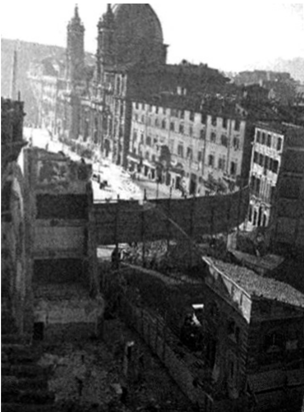
Figura 10. Demolições no hemisfério norte da Piazza Navona, 1935-1940
