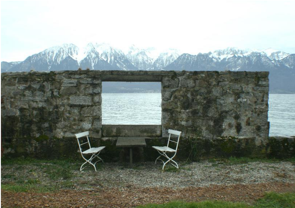
Figura 7 – Muro que resguarda jardim da Villa «Le Lac» de Le Corbusier, Vevey, Suíça
