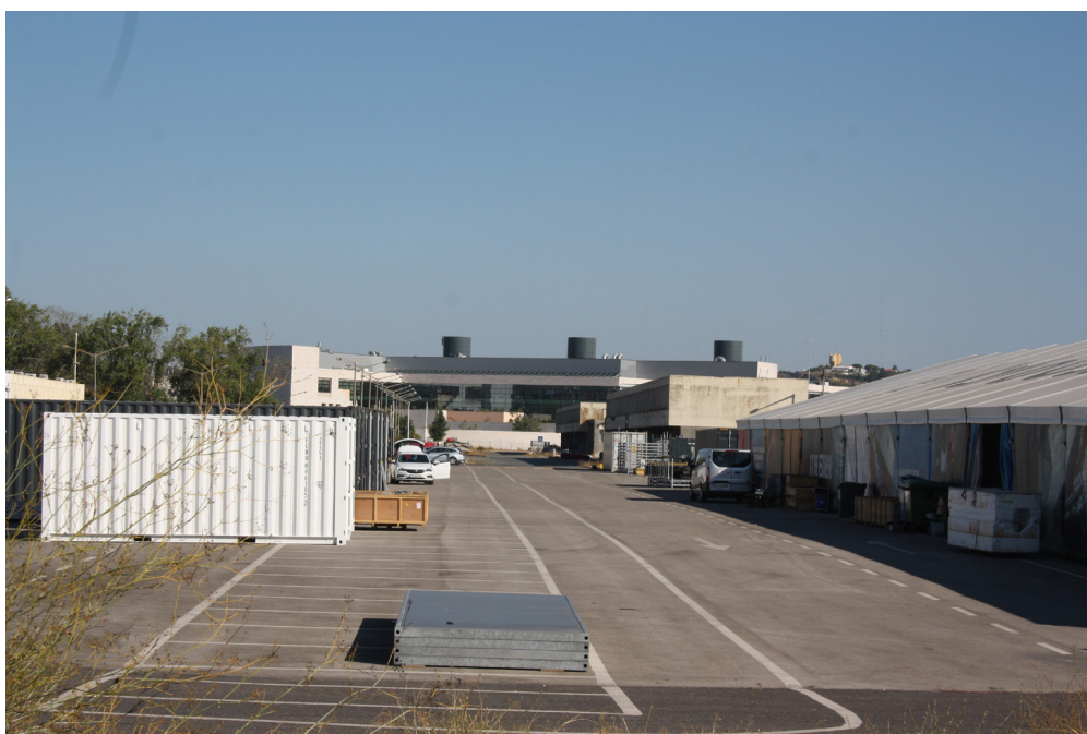
FIGURA 85 Tardoz dos edifícios da lota. Fotografia do autor.
