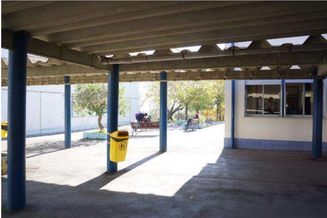
Figura 5 – Vista das coberturas da Escola de São João da Talha
