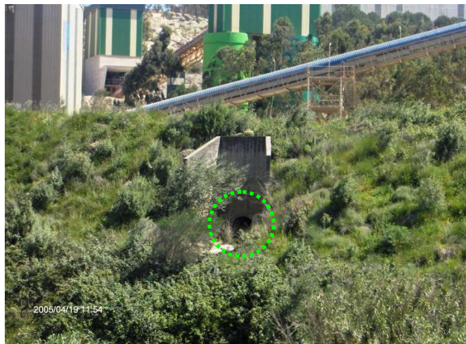
Figura III.11 – Ponto de descarga de águas pluviais tratadas provenientes da área adjacente ao Britador O&K (EH14).
