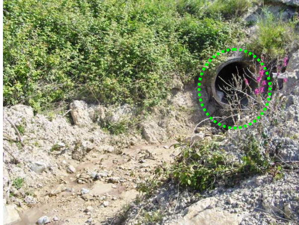
Figura III.10 – Ponto de descarga de águas pluviais tratadas provenientes da zona do Britador Krupp e de abastecimento de gasóleo da pedreira (EH13).
