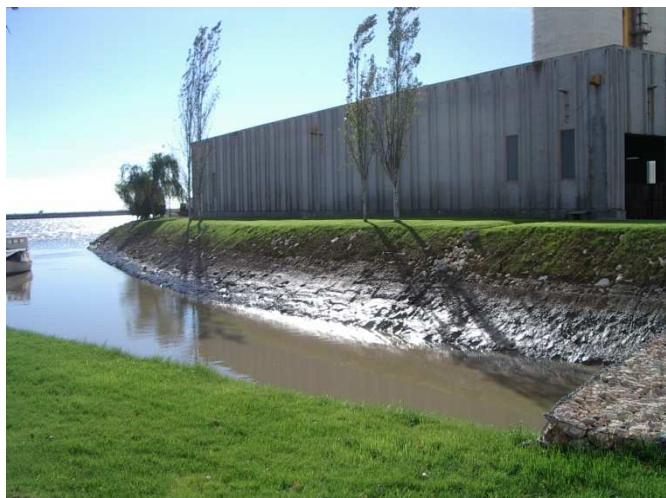
Figura III.6 – Troço final da Ribeira de Santo António (a jusante dos pontos de descarga EH1 a EH3).
