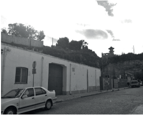
V.6 - construções degradadas e edificado desqualificado cuja demolição é prevista, no entanto o seu limite é decisivo, como referência na limitação da implantação da proposta, pela coerência do traçado urbano e delimitação do quarteirão.
