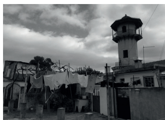
V.2 - mirante e construções ilegais a oeste da linha do caminho de ferro
