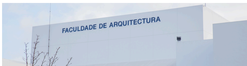
Figura 19 | Fachada Oeste, Pavilhão 1 – FAUL . Fotografia
