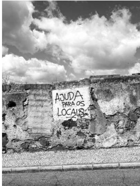
Figura 3. Muro do terreno da Quinta das Damas.
