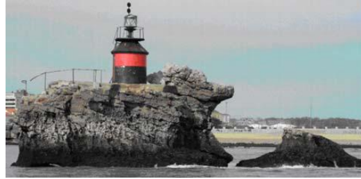
Fig. 3 – A “Horadada” depois do colapso
