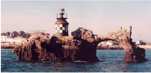
Fig. 2 – A “Horadada” antes do colapso
