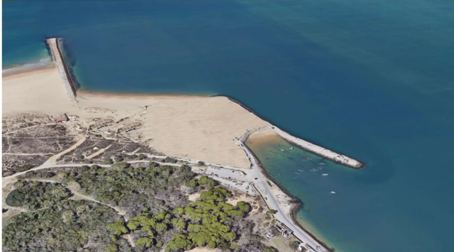
100. Cenário de adaptação para a Cova do Vapor, retirada total das habitações.
