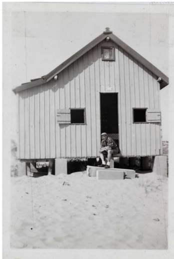
76. Tipo de construções, sobre estacas.
