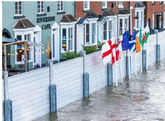
54. Barreiras de inundação criadas para proteger Bewdley de inundações, Inglaterra.
