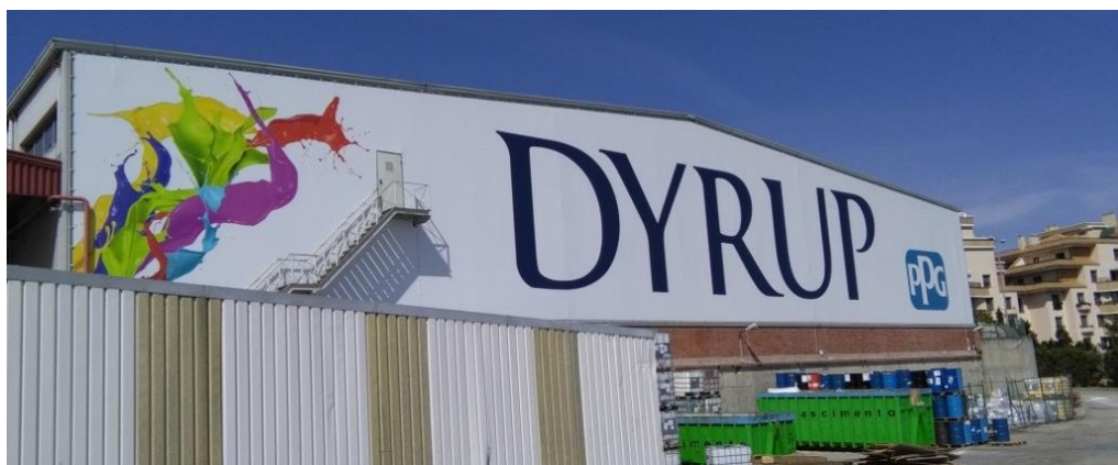
Figura 4.10 - Vista de lado do telhado com orientação Este
