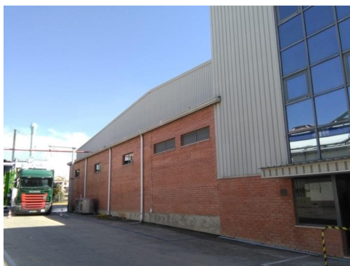
Figura 4.11 - Vista de lado do telhado com orientação Oeste
