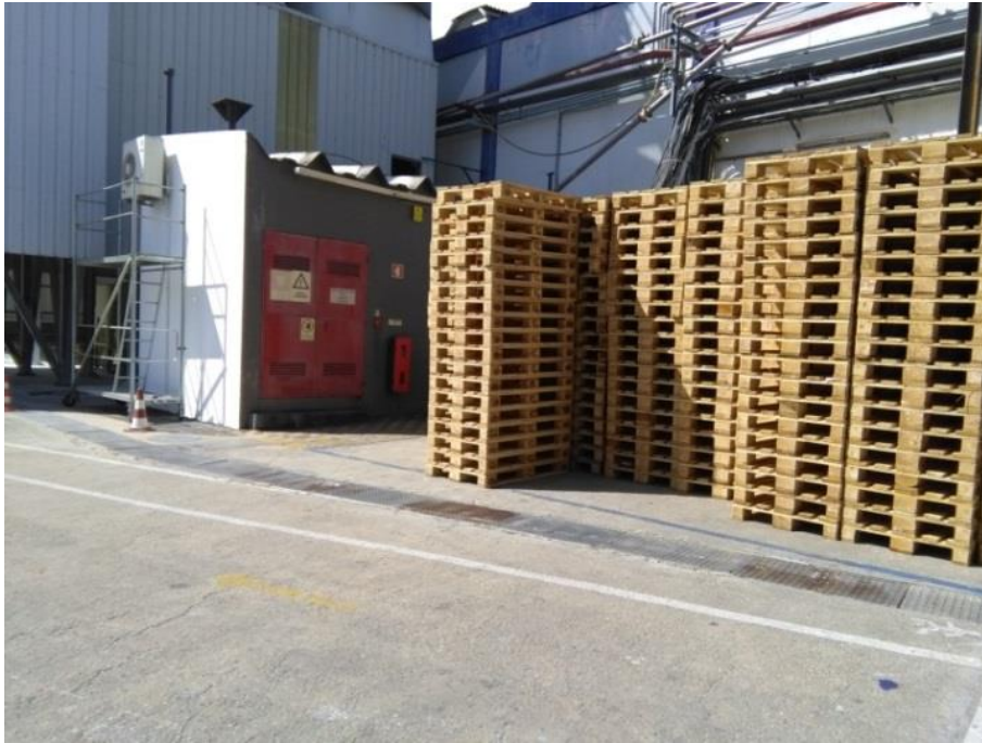
Figura 4.15 - Vista exterior da sala onde será feita a interligação e a colocação dos inversores
