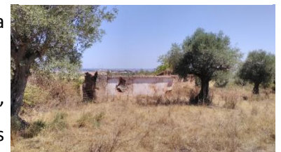
Fig. 62 exemplo ruína habitação
