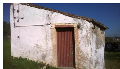
Fig. 86 casa dos caseiros
