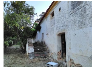
Fig. 38 utilização da taipa
