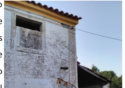
Fig. 37 utilização da cal
