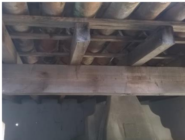
Fig. 36 estrutura de cobertura em madeira
