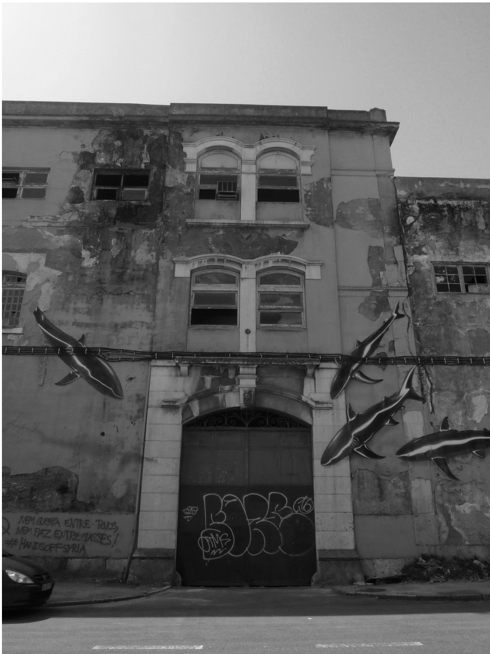
43, 44 e 45. Alçado Norte do edifício principal do conjunto Abel Pereira da Fonseca. 2018. Fotos da autora.
