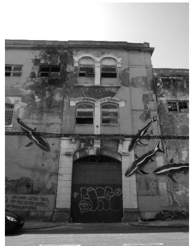
Fig 38. Degradação dos edifícios industriais.
