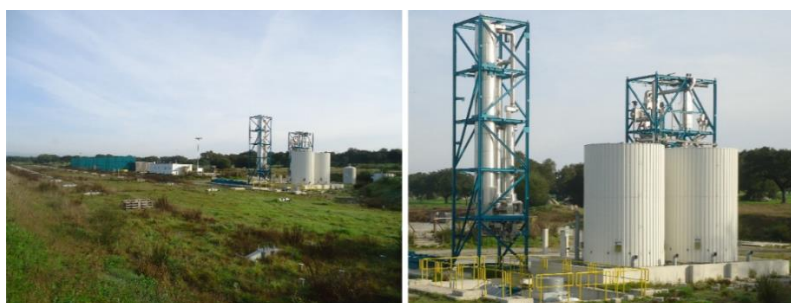
Figura 3.3 - Processo da construção da central PTCs da Herdade da Mitra/Évora. Na figura do lado esquerdo tem-se acesso ao tamanho do parque em que já existem duas filas com fundações já instaladas e do lado direito encontra-se em ponto maior as duas torres para geração de vapor e dois tanques de armazenamento térmico com sais fundidos [Foto do Autor].
