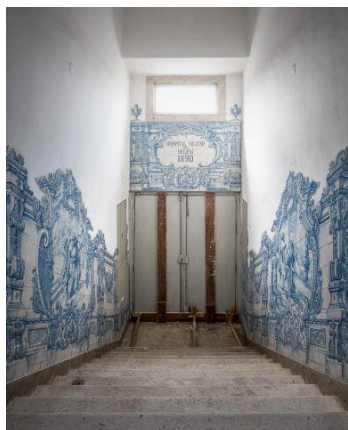
23. Porta de acesso na ala sul, ao Hospital Militar de Belém, 2019
