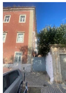
26. Portão junto às habitações já existentes, 2022
