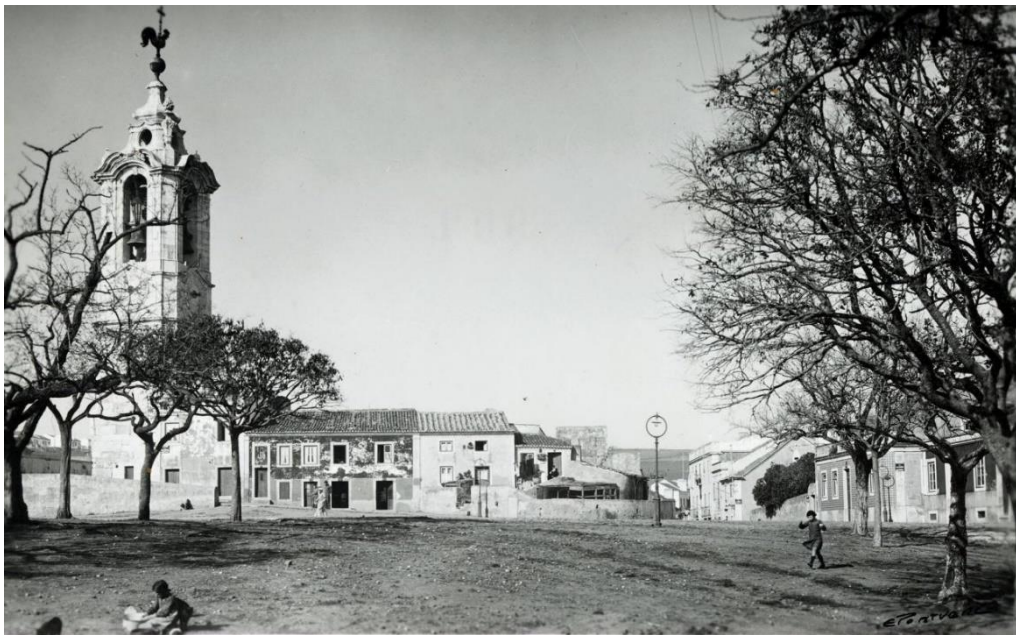
Vista da Rua da Torre. Fotografia de Eduardo Portugal, Junta de Freguesia da Ajuda,
