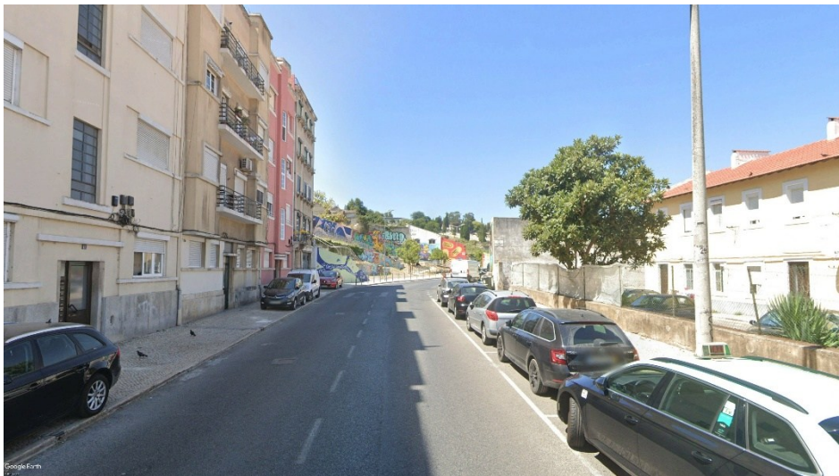
Figura 30 - Situação atual do Corte AB, sentido Sul-Norte (Fonte: Google Earth Pro; data: 08/2024)
