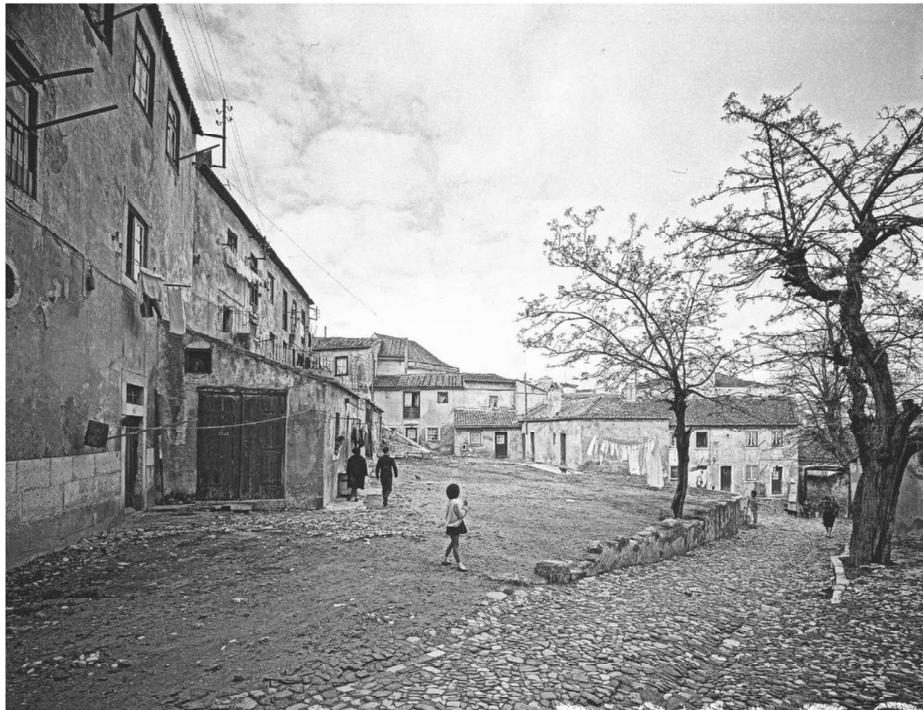
Fig. 34 – Pátio de Dom Fradique (também conhecido por Pátio de Dom Fradique de baixo), 1968
