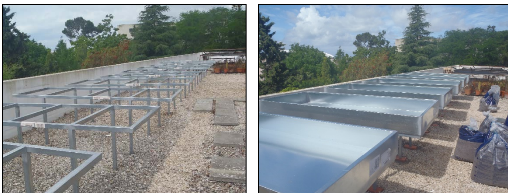
Figuras 35 e 36 – Estrutura para acondicionar os tabuleiros; tabuleiros já no local estipulado (19 e 23 maio de 2014)
