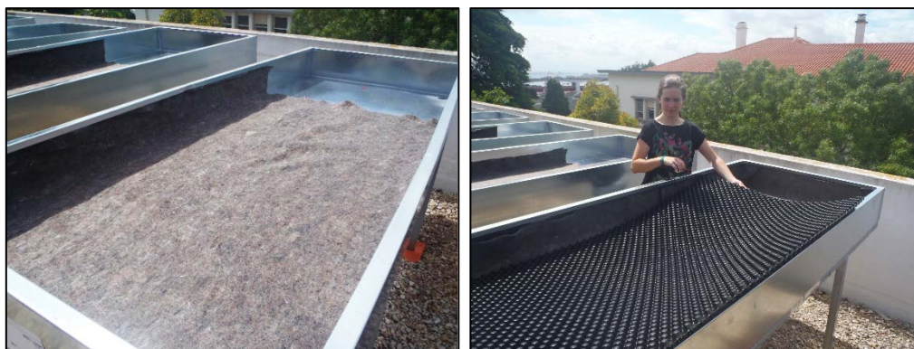
Figuras 37 e 38 – Tabuleiro com a manta de proteção e retenção; colocação do elemento de drenagem (23 de maio de 2014)
