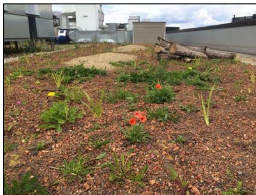
Figura 13 – Exemplo de Brown Roof (Fonte: ecogreenroofs.co.uk)
