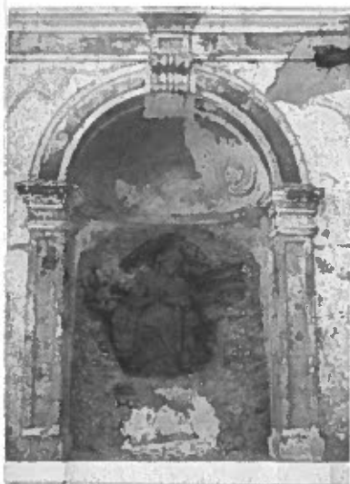
Fotografia do Convento S. Paulo de Ossa. Jardim dos Noviços: nicho com escultura em terracota
