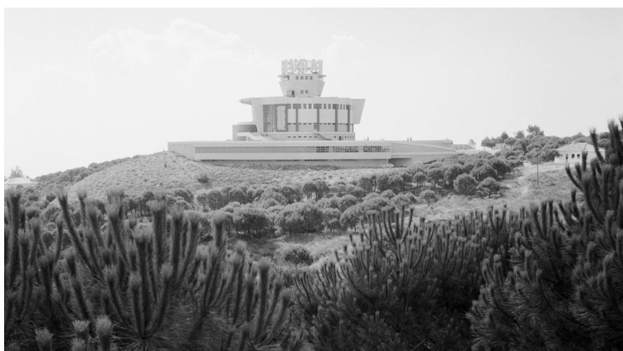
050. Vista lado Nordeste do Restaurante Panorâmico de Monsanto, 1967. Chaves da Costa 051. Alçado Norte do Restaurante Panorâmico de Monsanto, 1967. Chaves da Costa
