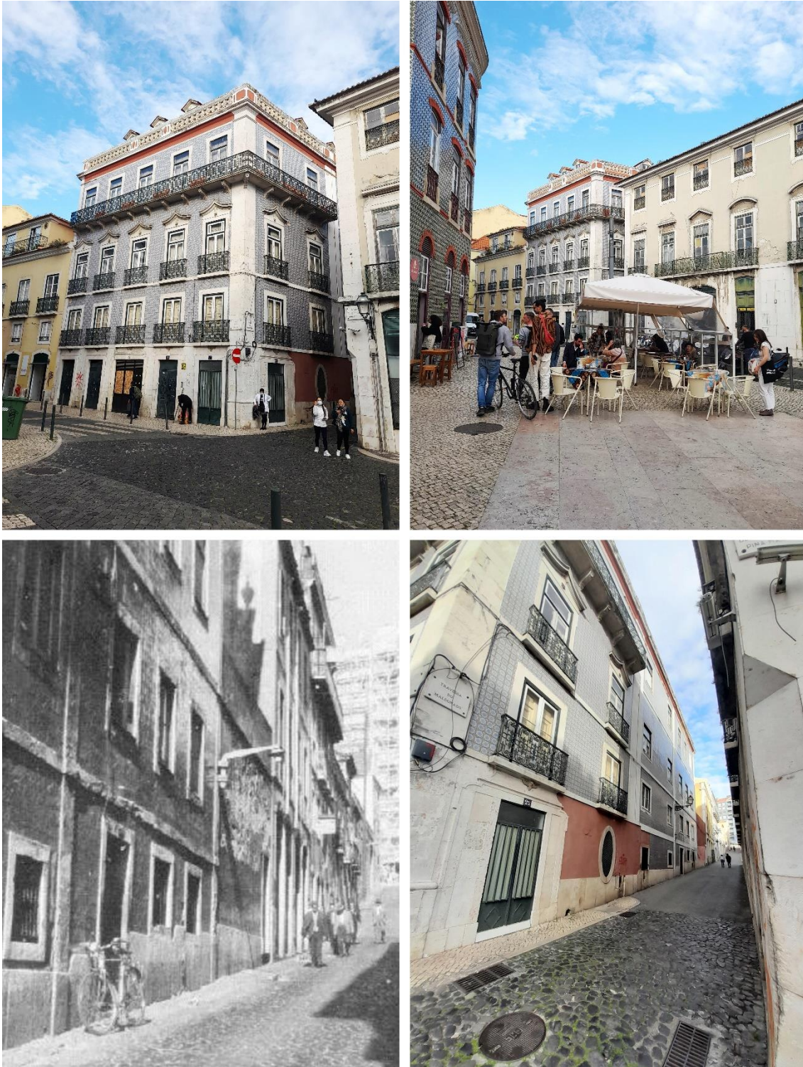
Fig. 7.12 – Da esquerda para a direita e de cima para baixo: alçado principal para a rua dos Anjos; Largo do intendente, vista para o edifício; Fachada lateral para a Travessa do Maldonado antigamente (1964) e atualmente (Fotografias atuais da autora, 2022 e Fotografia antiga de autor desconhecido, 1964)
