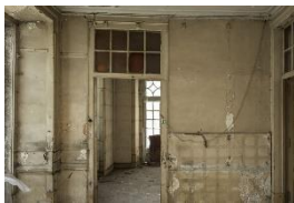
Fig. 5.10 – Aspeto do interior do edifício antes da obra (Foto de Nuno Almendra, 2020)
