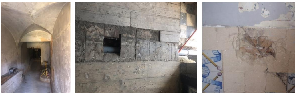
Fig. 6.11 – Da esquerda para a direita: abóbadas de aresta no piso térreo; pavimento e vigas de madeira; parede de frontal (Fotografias de Vasco Appleton, 2020)
