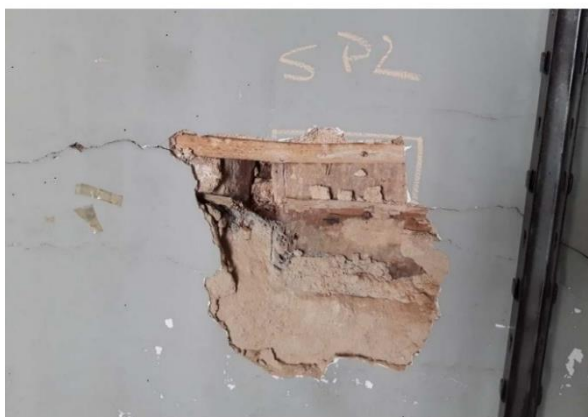
Fig. 7.10 – De cima para baixo: sondagem estrutural do caso de estudo na Rua dos Anjos, 2: Parede de alvenaria de pedra; parede de frontal; parede de tabique (Fotografias de Vasco Appleton, 2019)
