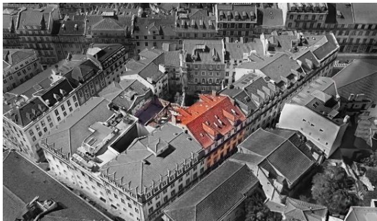
Fig. 6.1 – Fachada principal, quarteirão e anexo em ruínas (Adaptado do Google Earth, 2022)
