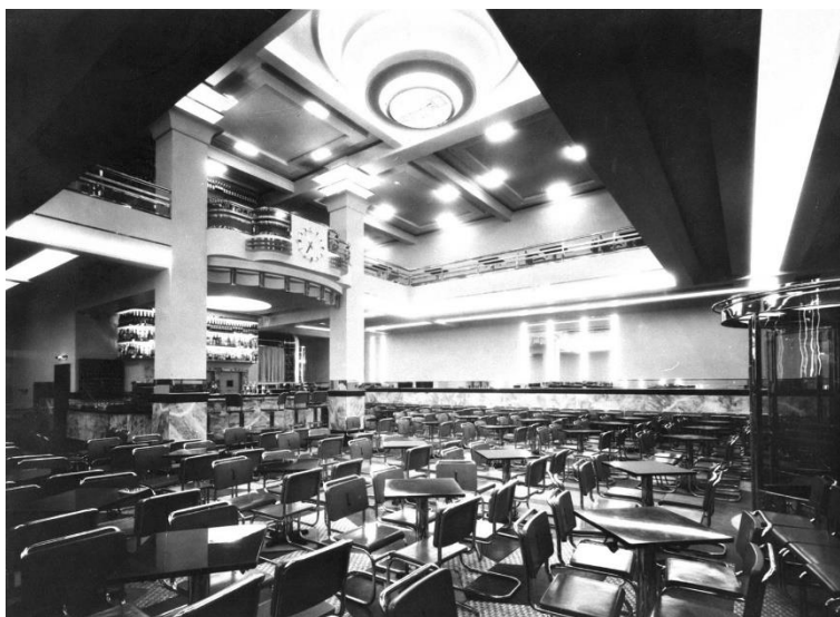
Anexo 44 – Interior de um dos salões, 1947 (Fotografia dos Restos de coleção, 2012)
