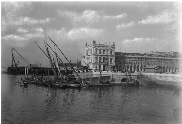
Fig. 5.5 - Cais das colunas (Terreiro do Paço), início do século XX (Fotografia de autor desconhecido, s.d.)
