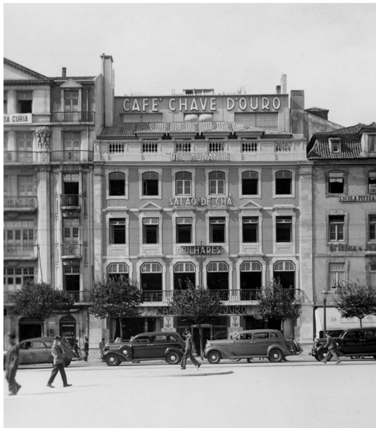
Anexo 43 – Fachada principal, anos 40 (Fotografia dos Restos de coleção, 2012)
