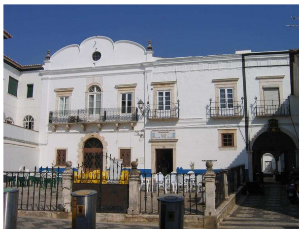
Fig. 2 - Fachada principal da antiga igreja
