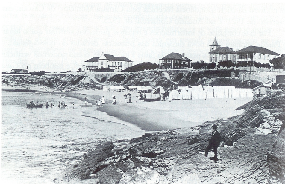
Figura 61. as primeira rampas para a praia, início do séc. XX in , Parede as pedras e o mar, Monografia da Parede, AA.VV. Parede, Junta de Freguesia da Parede, 1997, p.186
