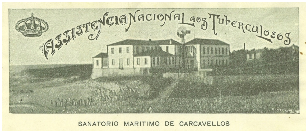
Figura 14. Sanatório Marítimo de Carcavelos, c. 1900 Arquivo Histórico Municipal de Cascais, AHMC-AESP-CALM-084
