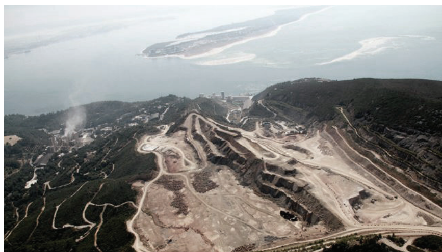
23. As duas pedreiras contíguas da Secil, 2010
