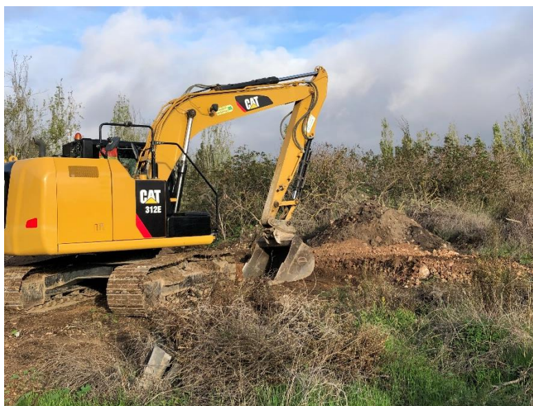
Figura 8.4. Exemplo da escavação de um poço e divisão em depósitos temporários
