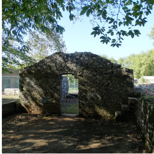
038. Fotografias Real Fábrica do Gelo, Serra de Montejunto, (2019).
