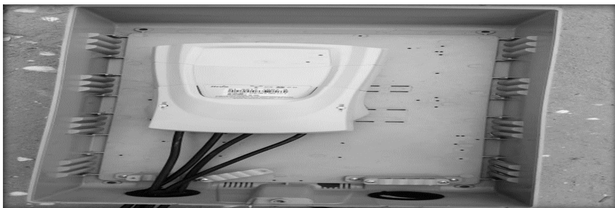
Figura 4.22. Contador elétrico pré-pago exterior - baixa tensão e “trifásico”: componente digital do setor Fonte: (Visita guiada a locais de intervenção da equipa de pré-pago, município de Cacucio, em Luanda).
