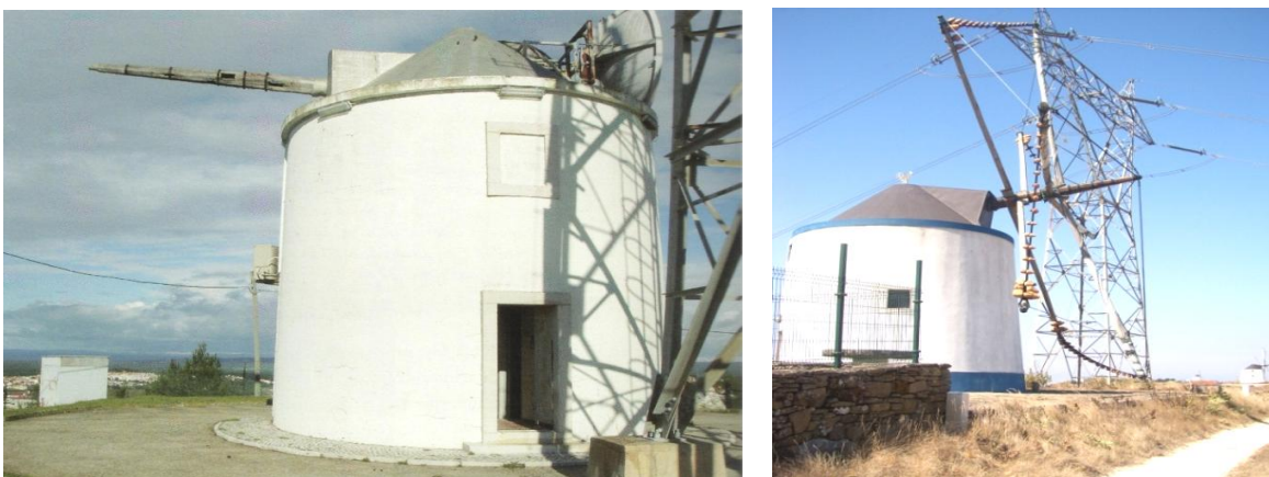
Fig. 21 | Aspecto actual do moinho do “Ti” Virgílio, reconvertido em terminal de telecomunicações para recepção de cabos submarinos e posto de transmissão, em Facho de Santana. Fonte: CMS, 2012:72. Fig. 22 | Moinho de vento do Oeste junto a poste de alta tensão junto a em Vilar, Cadaval. Fonte: Fotografia da autora.
