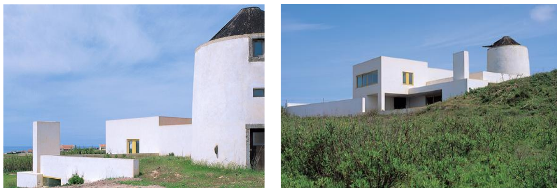
Fig. 56 | Fotografia da casa Rui Jordão. Fonte: http://www.joseneves.net/pt/imagens/Jose_Neves-Casa_Rui_Jordao_01.jpg 01/06/14 23:00 Fig. 57 | Fotografia da casa Rui Jordão. Fonte: http://www.joseneves.net/pt/imagens/Jose_Neves-Casa_Rui_Jordao_15.jpg 01/06/14 23:00
