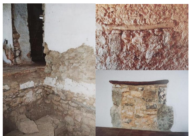
F.18 ← Vestígios da existência de um nível de pavimento mais antigo (IPPAR, Maria Ramalho)
