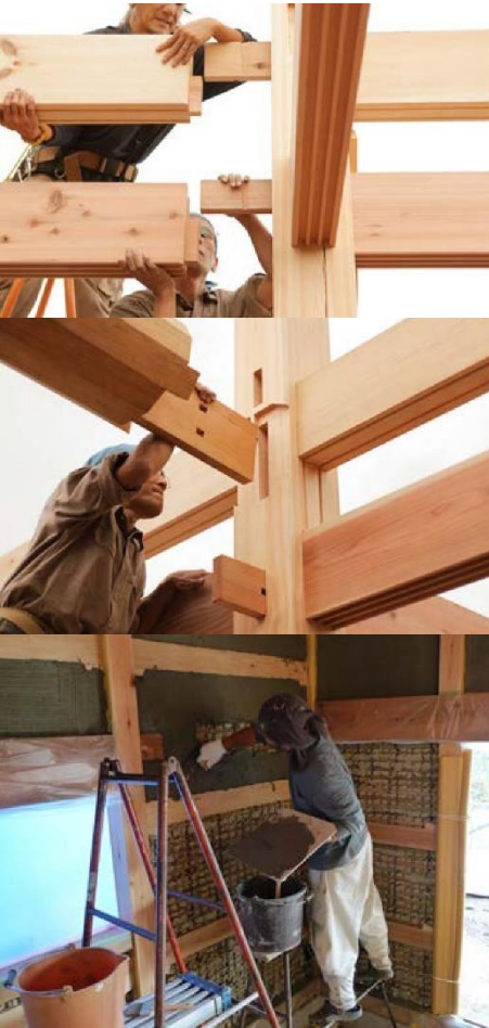
F.26 ↑ ← Montagem da armação da Casa Kamogawa (Ken Kusakari)
