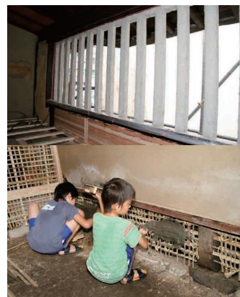
F.41 Remoção de painéis das paredes e cobertura ( Kyoto Machiya Revitalization Project )
