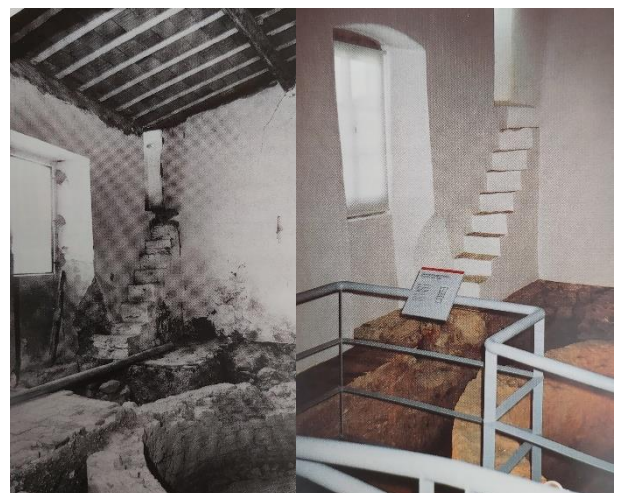
F.20 Estruturas arqueológicas romanas à vista antes e depois do restauro (IPPAR, H. Ruas e Maria Ramalho)
