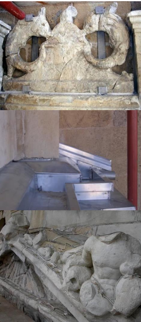
F.12 Reforço estrutural de um elemento escultórico (Nova Conservação S.A.)
