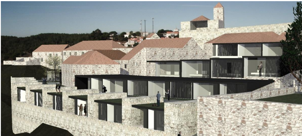
Figura 46 Fotografia do quarto junto à muralha e da vista geral sobre a zona nova
