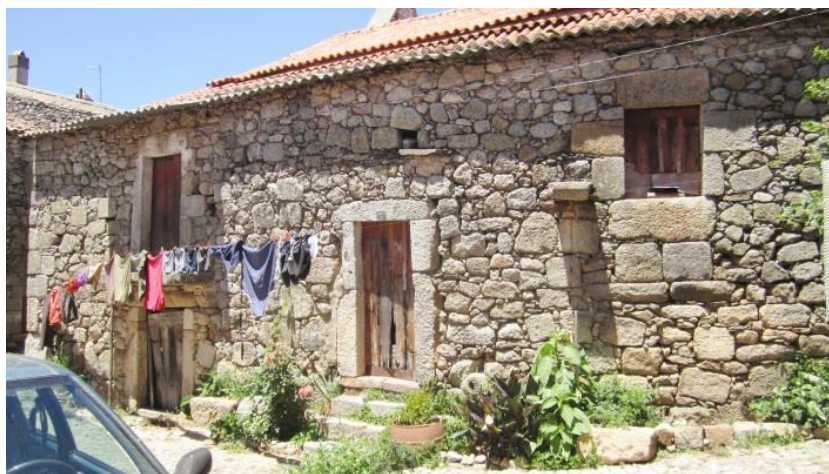
Figura 21 Casa construída em granito, em Penamacor
